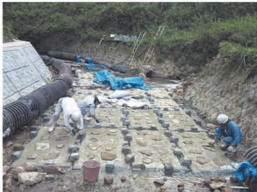
2t標準施工 植石施工
