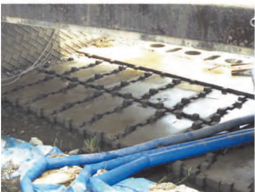
2t標準施工 橋梁下施工
