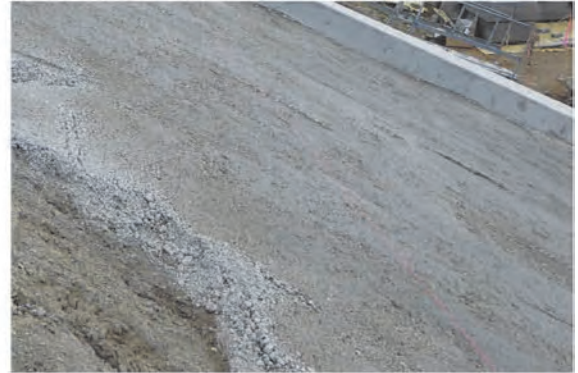
② ブロック下が裏込材の場合、所定の暑さで敷き均し転圧する。
