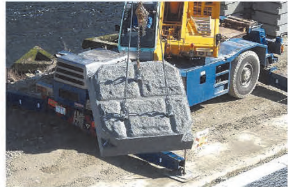
④ ブロックは専用の吊り金具を確実に取り付ける。
