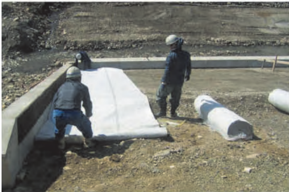
③ 吸出し防止材の場合たるみの無いよう敷設する。
