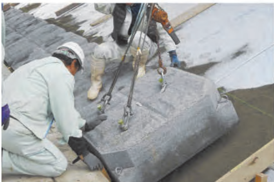
⑤ ワイヤー長さを勾配に合わせて製品を据え付ける。
