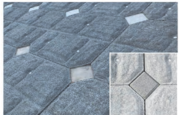
⑧ 連結部は間詰コンクリートを充填する。 間詰ブロックを使用する場合はこの上に貼る。
