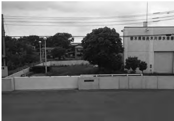
設置完了状況
