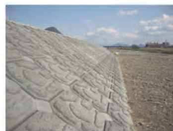
連結部着色コンクリート処理
