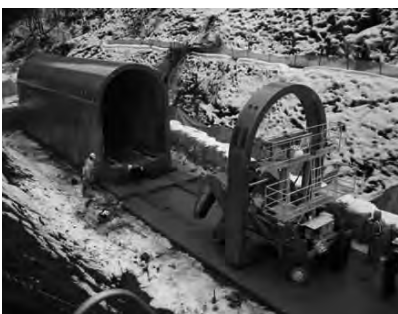
アーチカルバート (山間部、勾配施工)
