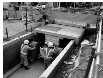
現場打ちスラブ (市街地)
