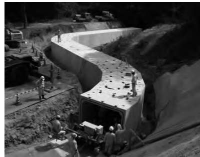
ボックスカルバート (山間部、勾配施工)
