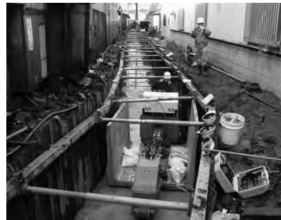
三面水路 (市街地)
