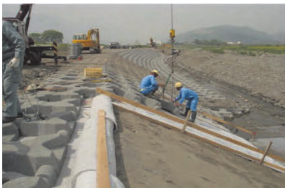
天端・法面部施工状況
