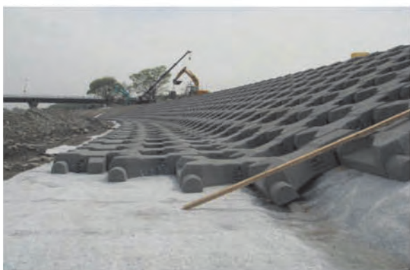
垂部施工状況
