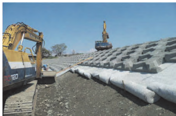
法面部施工状況
