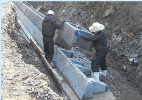
③ 2 段目以降、本体ブロックを据付
