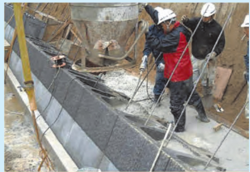
⑥胴込コンクリートを所定の胴込め部に打設
