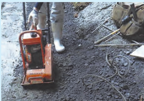
⑦抜き型枠を撤去し、裏込め材を転圧
